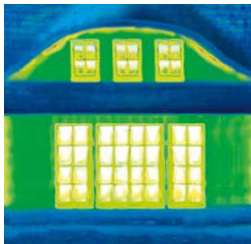
Po renowacji - zminimalizowane straty ciepła dzięki oknom z systemu profili GENEÓ.
